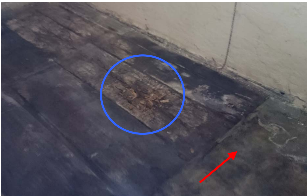
Obr. č. 2: částečně ztrouchnivělé desky dřevěné podlahy (modře); spodní strana linolea se stopami plísní (červeně)
